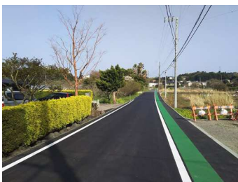
車のすれ違いや子ども通学時にも危ない道になっていましたが、通やすくなりました。
